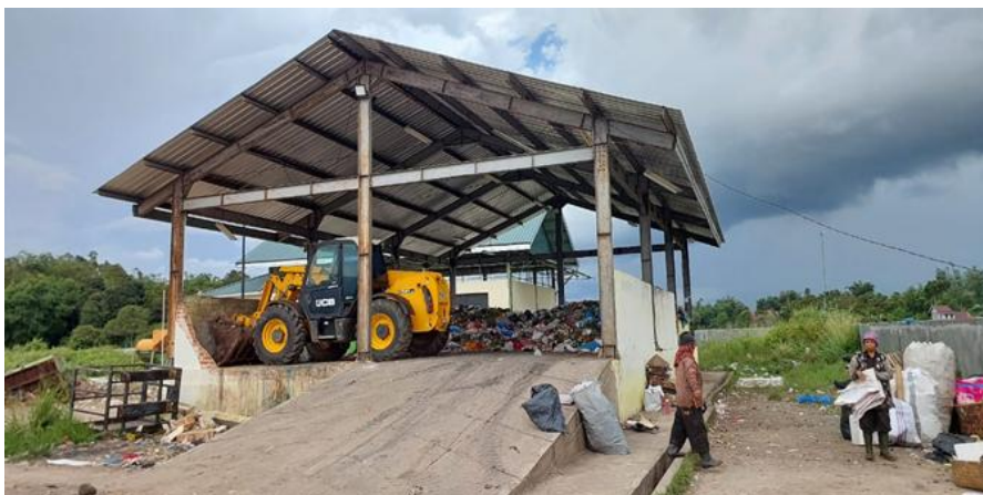
Gambar 2.66 Transfer Depo Kota Bukittinggi Sumber : Dinas Lingkungan Hidup Kota Bukittinggi, 2023
